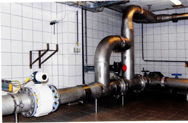
Hochbehälter Schesa Bauzeit 1965
