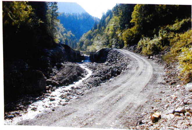
Acht Rückhaltesperren beim Alvierbach Bauzeit 2000 bis 2010
