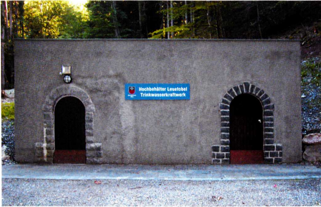
Hochbehälter Leuetobel mit Trinkwasserkraftwerk Bauzeit 1952/2005
