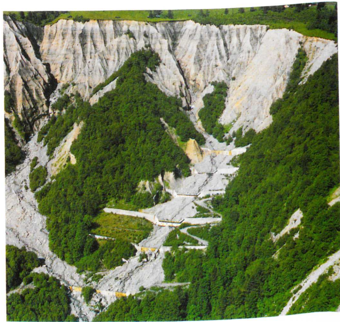
Schesatobelsperren Bauzeit um 1980
