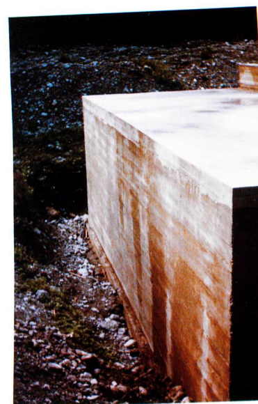
Bau des Hochbehälters in der Schesa 1965.
