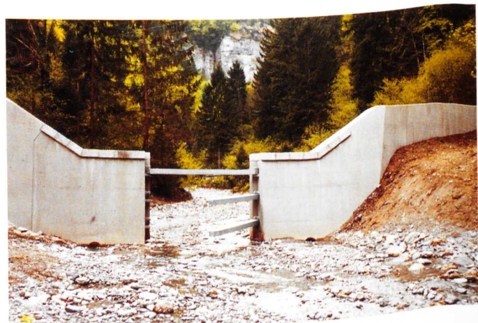
Rückhaltesperre beim Alvierbach Bauzeit 1981
