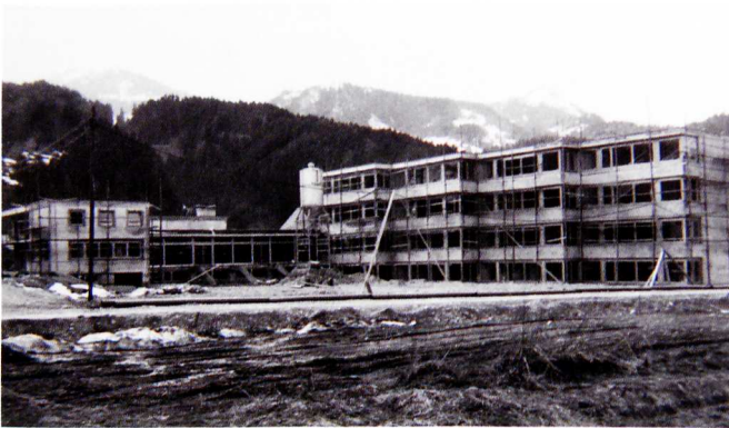
Bau der Volksschule / später Hauptschule Bauzeit 1966 bis 1968 Architekt: Ulrich Ender
