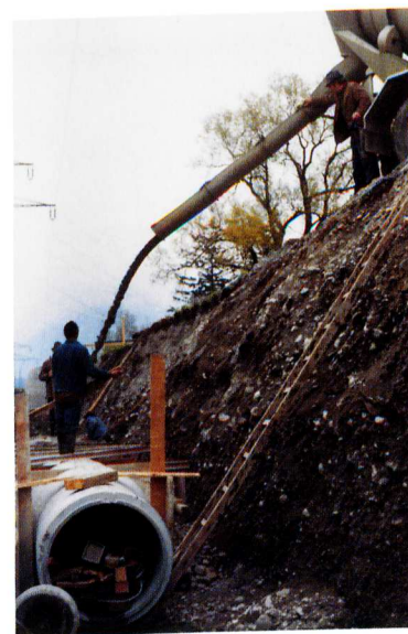
Kanalisierung im Schesagebiet – Verlegung des Hauptsammlers in die Auferau.
