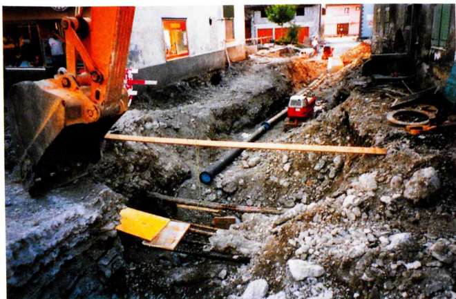
Erneuerung der gesamten Trinkwasserleitungen im Gemeindegebiet Bürs Bauzeit 1975 bis 1990
