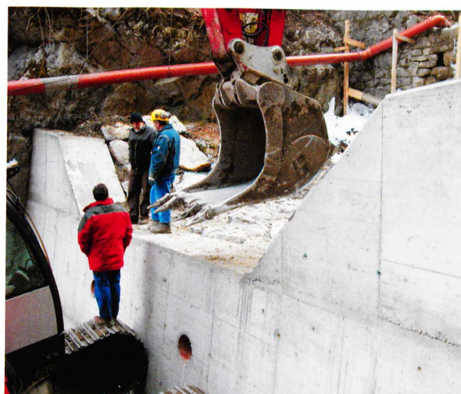
Sanierung der Sperre Leuetobel Bauzeit 2003
