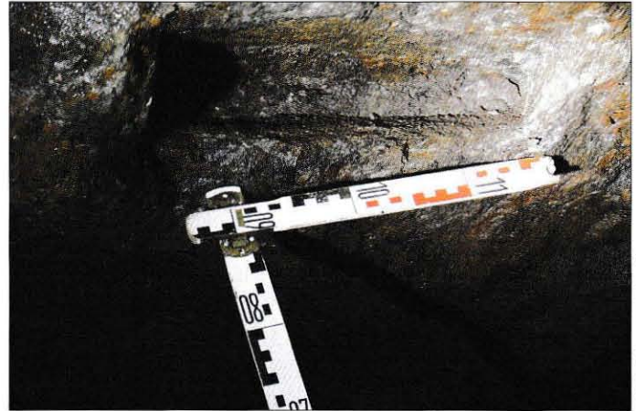
Abb. 4: Rest eines Keilschlitzes, der auf die im Schwazer Bergbuch 1556 beschriebene Abbaumethode mit Keilen hinweist.
