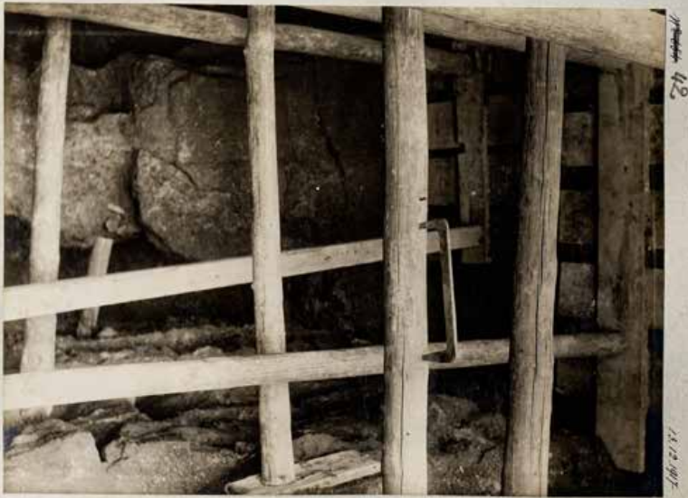
Stollenbau für Fundamentierung
