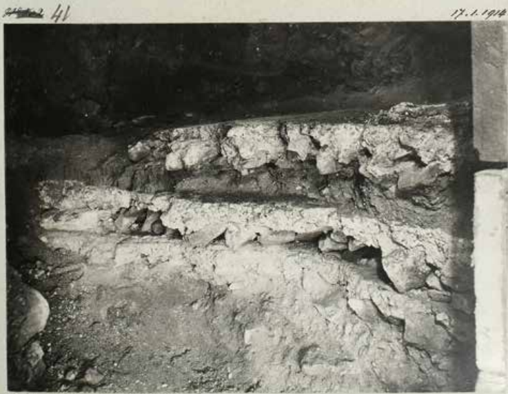
Spät-römische Fußböden im Fundament
