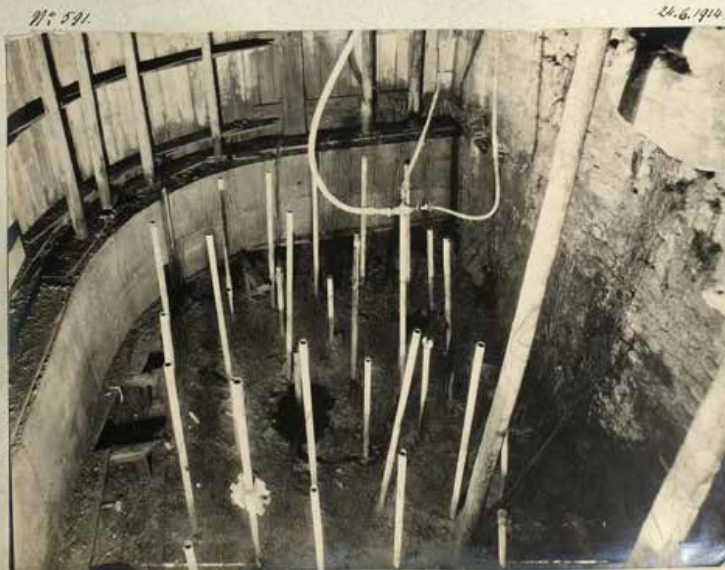
Einspritzrohre in die Kiesschicht m. Cementmilch.
