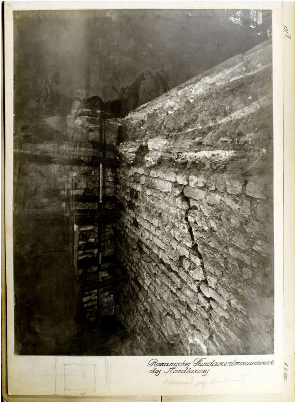
6.9.1911 | Romanisches Fundamentmauerwerk des Nordturmes | Ostwand geg Nordwand
