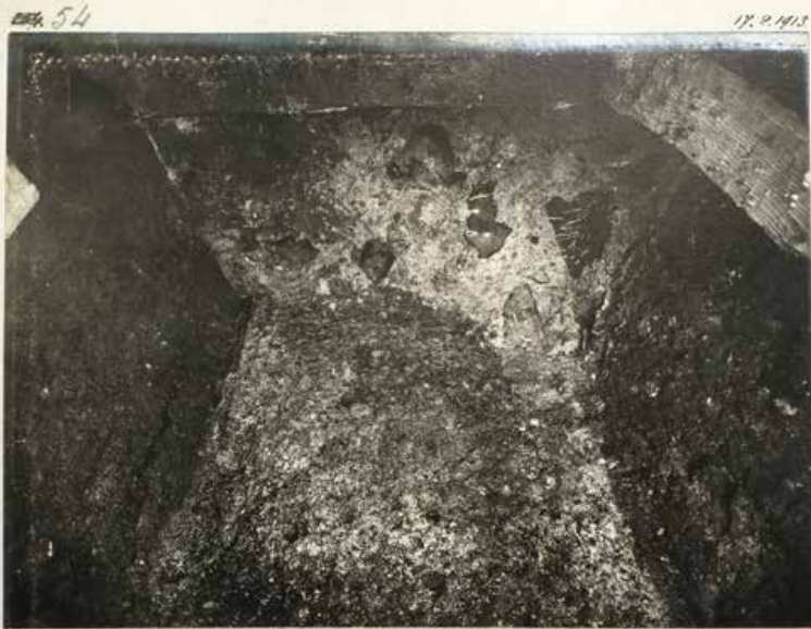
Sicht von unten aus Banket im I. Probeloch mit Spuren der Eichenholzpfahlköpfe.
