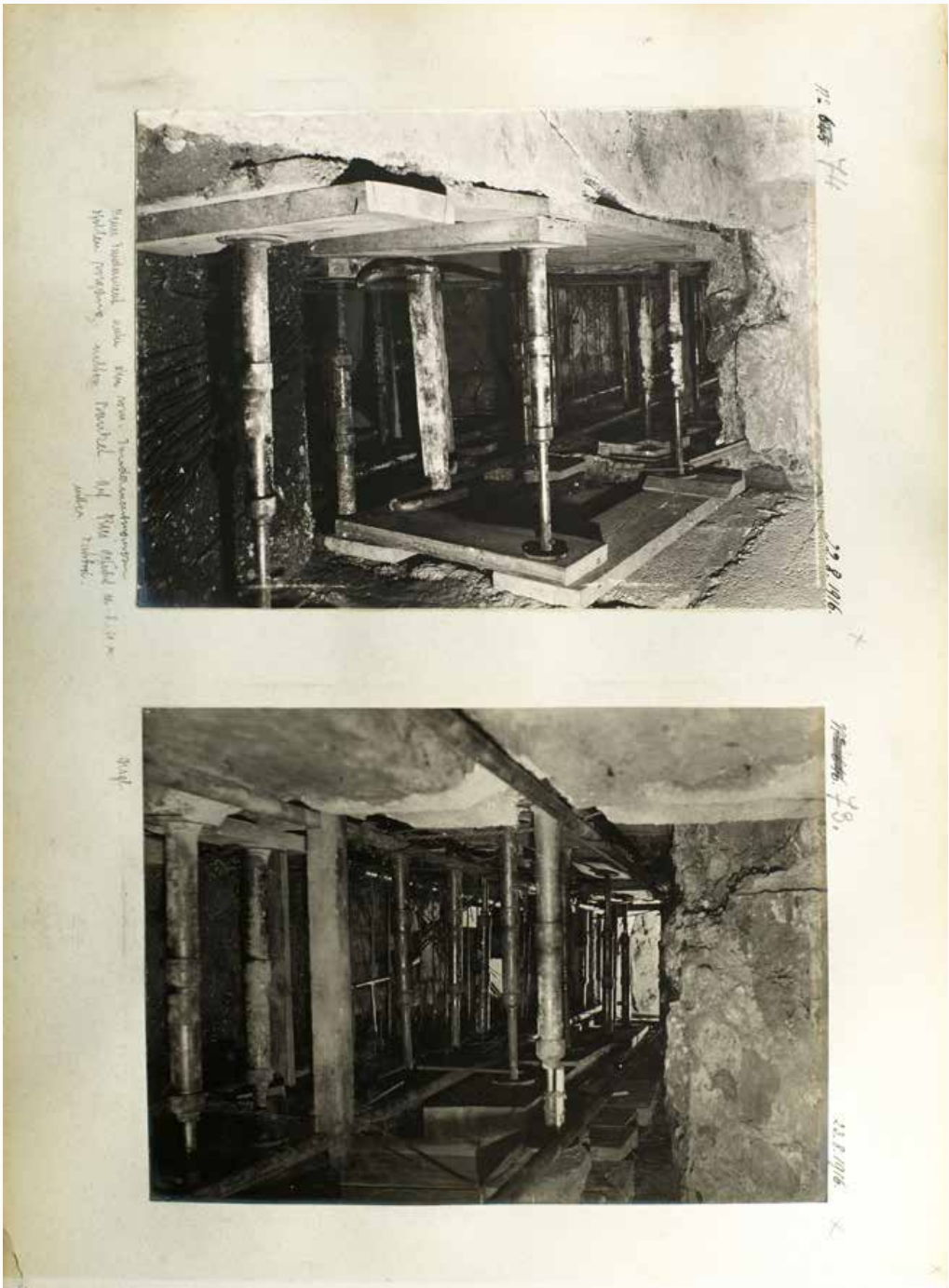
22.8.1916 Neues Fundament unter den rom. Fundamentmauern Stollen Vorgang unter Banket auf Kies geführt ca. 8-20 m unter Fußboden | 23.8.1913 Desgl.
