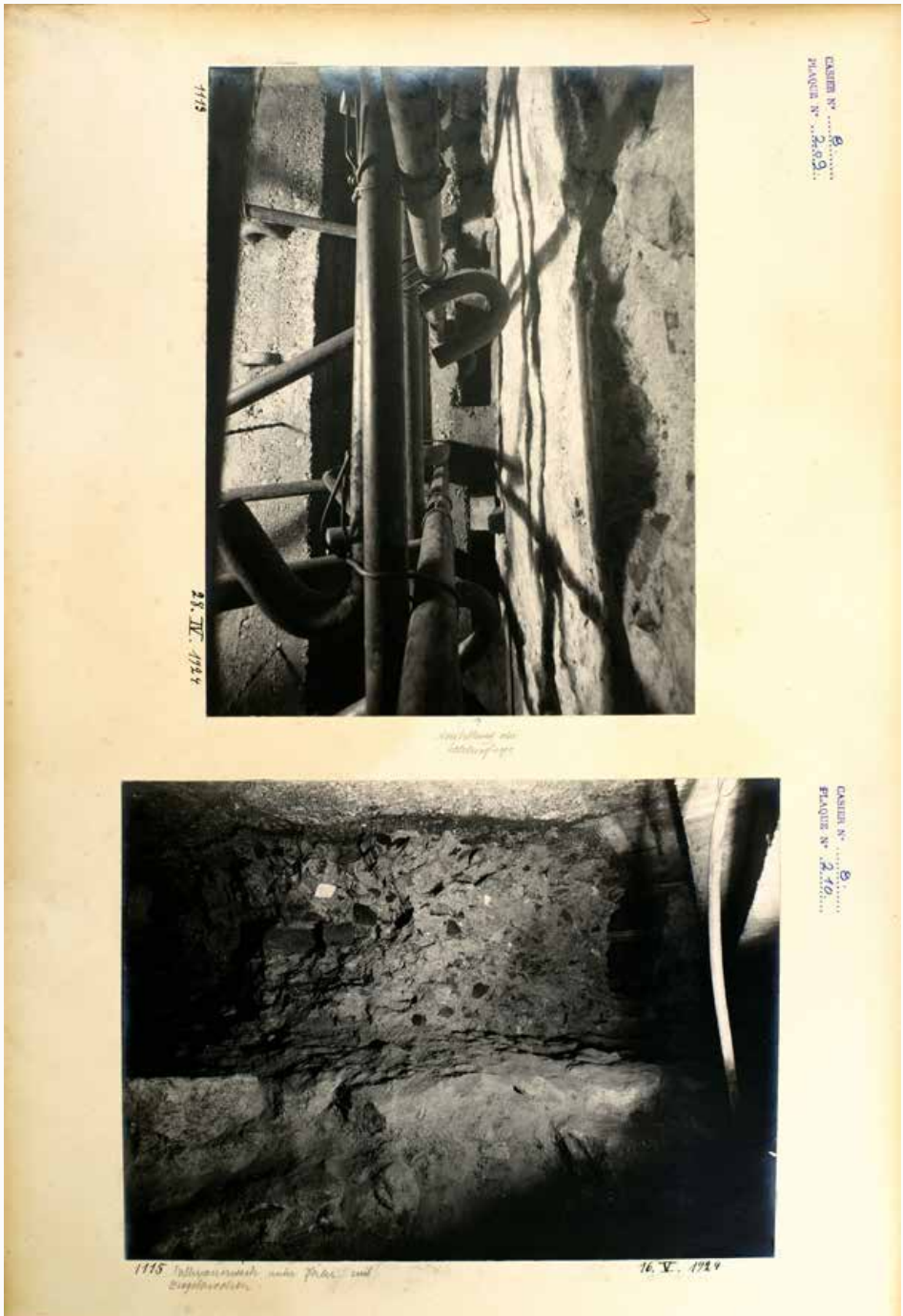
28.4.1924 Herstellung der Schlussfuge | 16.5.1924 Füllmauerwerk unter Pfeiler mit Ziegelbrocken
