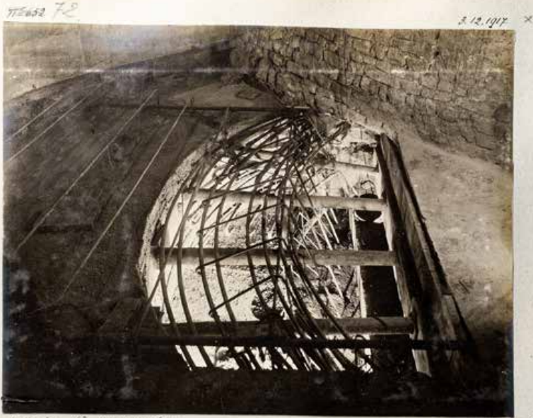
Stollenbau für Fundamentierung
