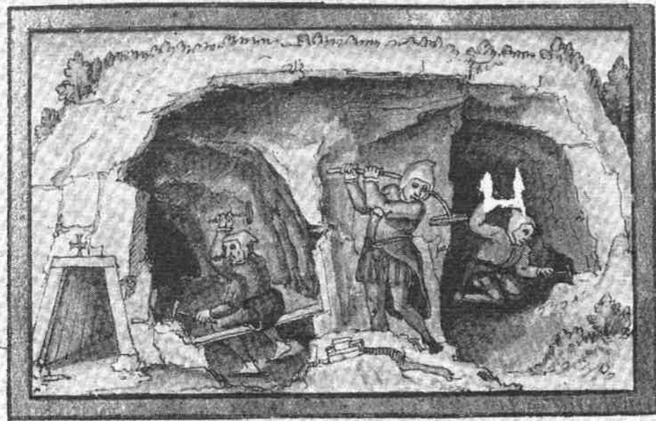
Bergknappen bei der Arbeit (Abbildung Schwazer Bergbuch)
