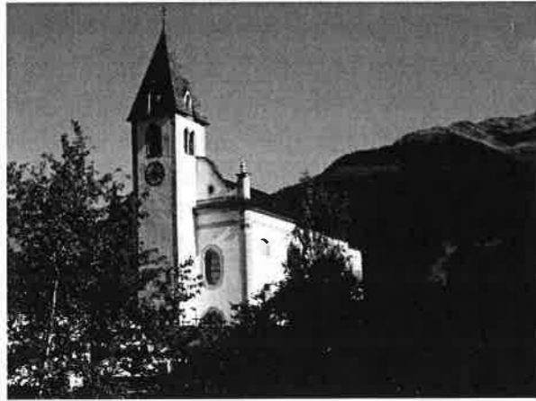
Abb. 1: Pfarrkirche Grins aus Richtung Westen aufgenommen
