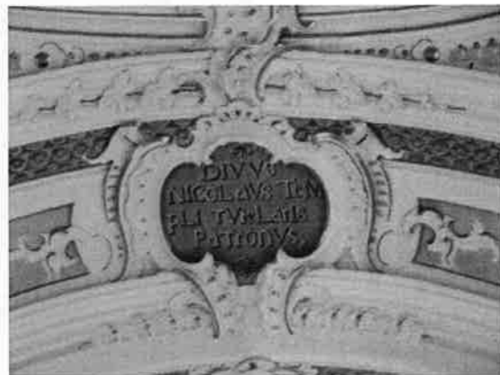
Abb. 2: Inschrift am Dach des Hauptschiffes, am Bogen vor der Apsis
