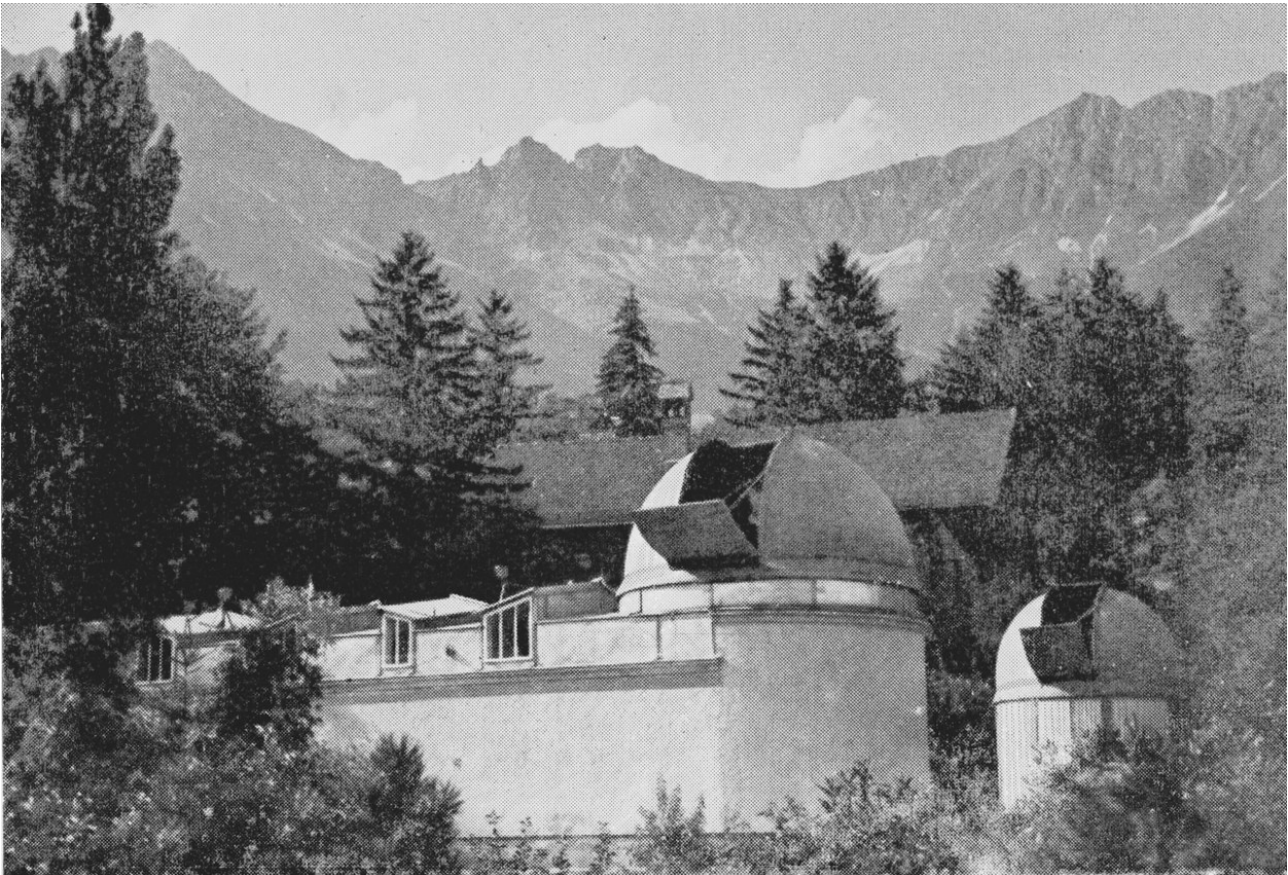
Abb. 18: Neu gestaltete Fassade der Sternwarte, Ansicht von Süden
