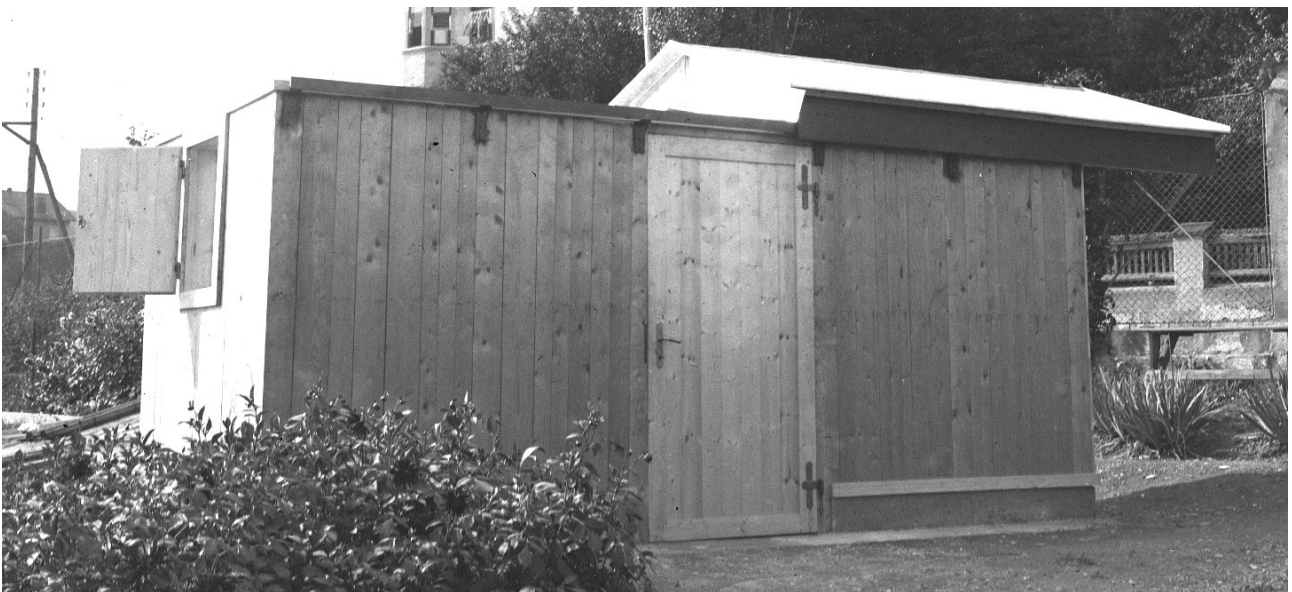
Abb. 25: Mobile Beobachtungshütte, aufgestellt nördlich der Sternwarte
