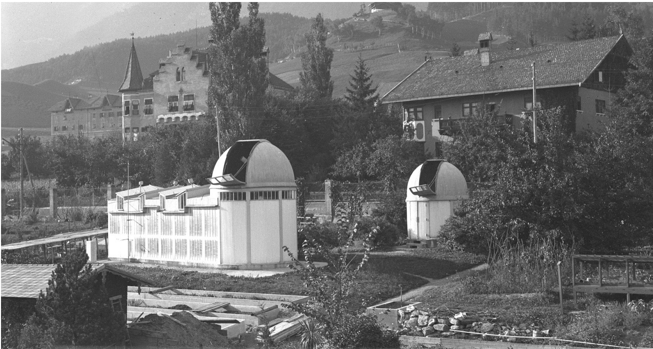
Abb.3: Universitätssternwarte Innsbruck in ihrem ursprünglichen Erscheinungsbild: Ansicht von Süden, aufgenommen im Sommer 1929, hinten rechts die Villa Oppolzer
