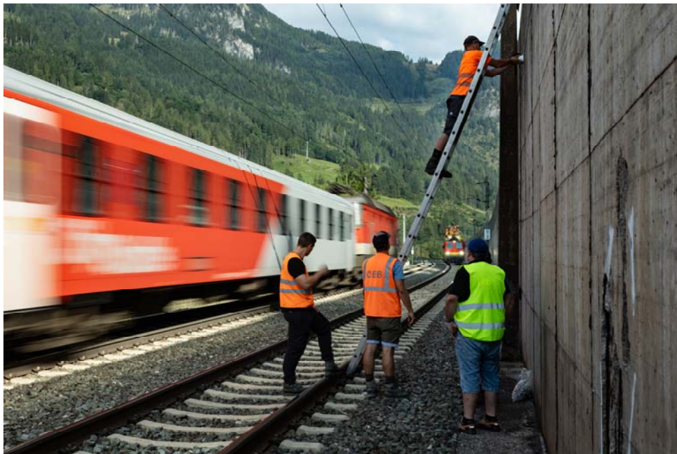
Abbildung 1: Installation von Neigungssensoren zur Überwachung einer Stützmauer im zugangsbeschränkten Gleisbereich
