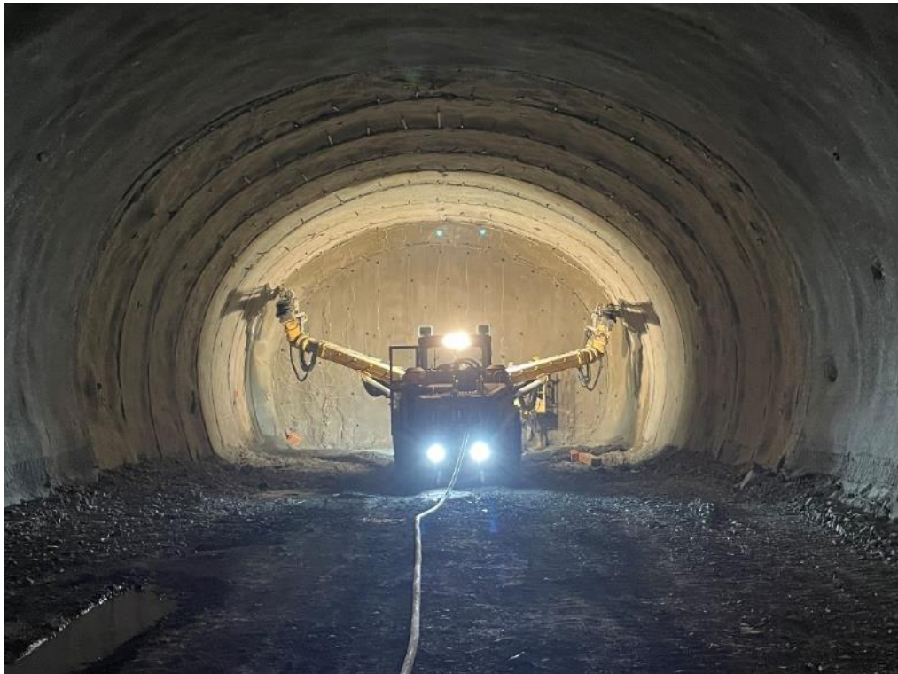
Abbildung 3-2: Bohrwagen im Einsatz
