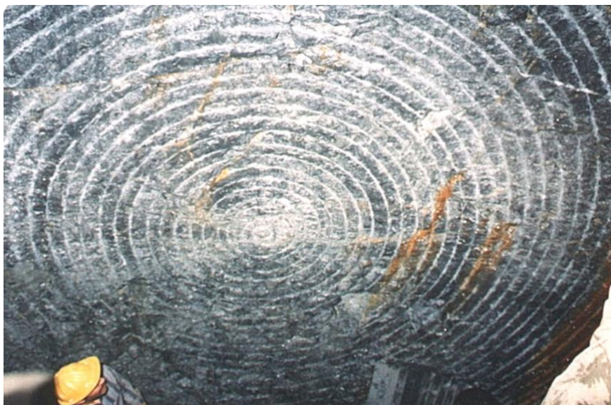
Abbildung 3-16: Abbild der Schneidspuren an der Ortsbrust [54]
