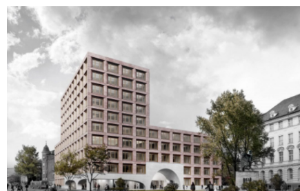
© mohr architekten ( https://www.mohr-architekten.at/projekte/universitaet-innsbruck-innrain-52a/ )
