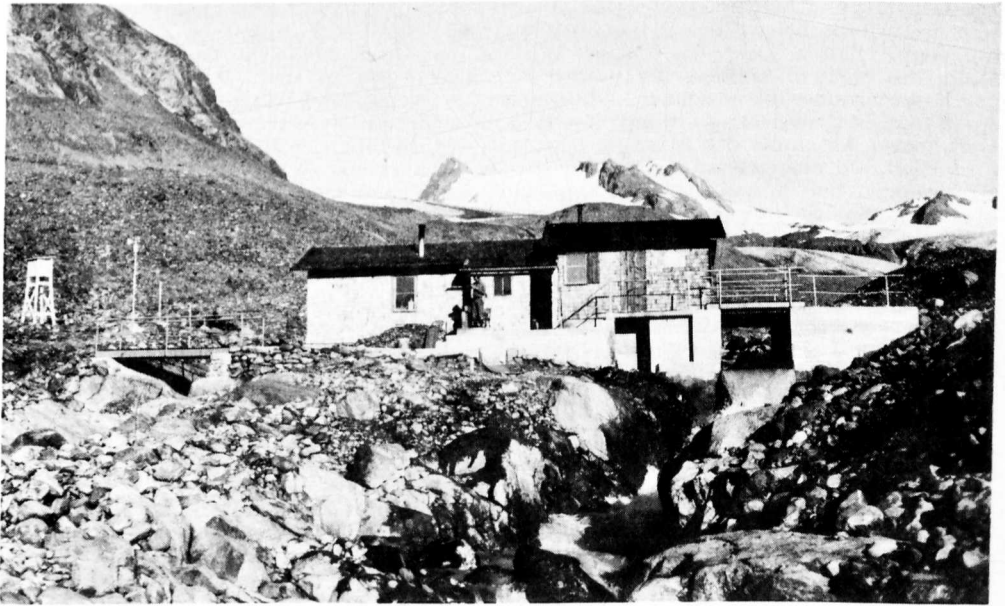
Abb. 5: Ansicht der Pegelstation Vernagtbach nach deren endgültiger Fertigstellung. Der im Bild links erkennbare Anbau mit Aufenthaltsraum und Materialdepot wurde im Sommer 1975 erstellt. (Aufnahme O. Reinwarth)
