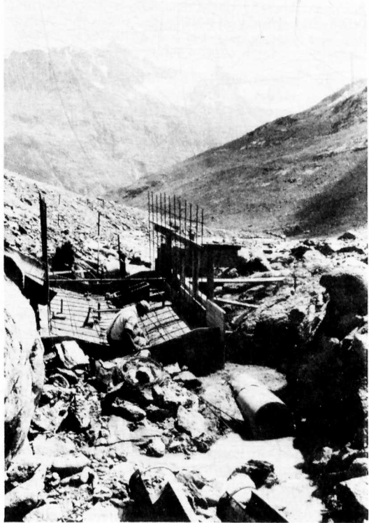
Abb. 4: Die Baustelle am Vernagt-bach im Sommer 1973: Die Fundierung der Meßrinne ist betoniert. Der Ableitung des Restwassers dient die Umlaufleitung, welche nach der Fertigstellung ein Trockenlegen der Rinne ermöglicht. In der Meßrinne ist die Schalung für den Meßschacht sichtbar.
