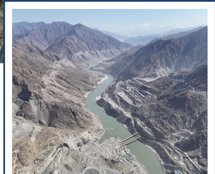
Die Talsperre staut den Indus zur Wasserspeicherung für Bewässerung und Abflusserhöhung außerhalb der Monsunzeit.
