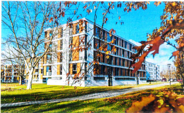
Wie können denkmalgeschützte Quartiere aus den 1960er Jahren denkmalgerecht erneuert und erweitert werden? Im Wolfsburger Quartier Wellekamp ist ein Beispiel zu besichtigen.
