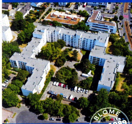
Bonn: Sanierungsprojekt mit 300 Wohneinheiten
